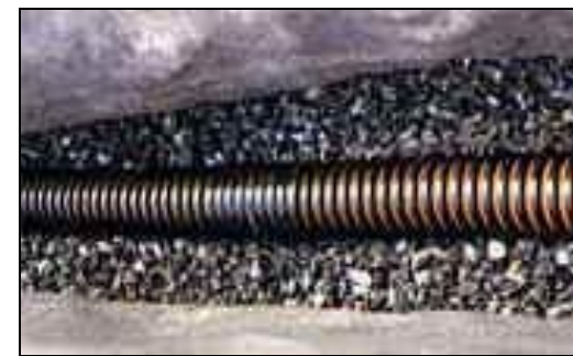
Figura 3.29 - Detalhe do Dreno Longitudinal
